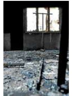
Patio de Luces del edificio. ALVEZ
