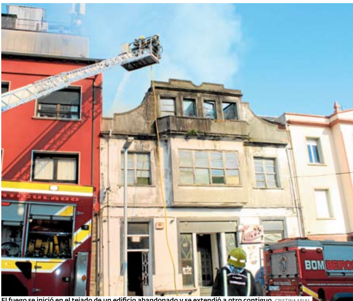
El fuego se inició en el tejado de un edificio abandonado y se extendió a otro contiguo. CRISTINA ARIAS
