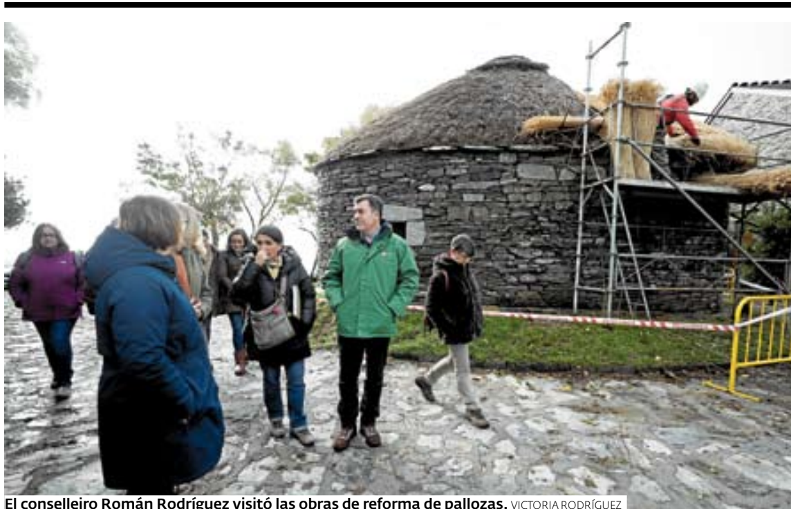
El conselleiro Román Rodríguez visitó las obras de reforma de pallozas. VICTORIA RODRÍGUEZ
